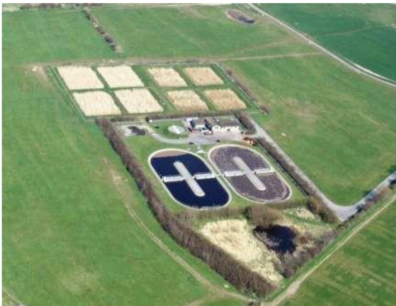
Foto: Rudkøbing Renseanlæg
